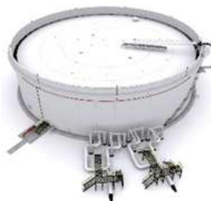
Резервуар вертикальный стальной с плавающей крышей (РВСПК)
