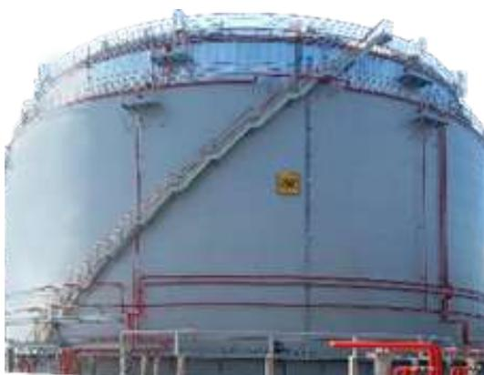
Цилиндрический резервуар с защитной стенкой («стакан в стакане») (РВСЗС)
